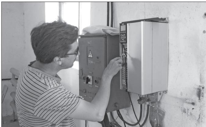
В с. Таврическом Красноперекопского района люди жаловались на постоянные перебои с водой. Причина — протекание водонапорной башни. Для того, чтобы исправить ситуацию в селе, а также в пгт Раздольное, служба ЭСО филиала предприятия выполнила монтажные и пусконаладочные работы двух частотных преобразователей мощно-
