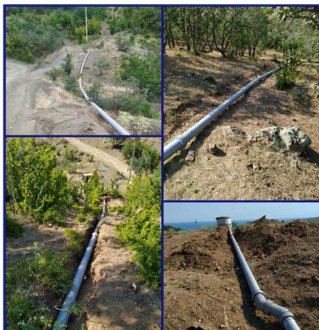
Ремонт участка водовода от источника водоснабжения родник «Калавата» до с. Генеральское. Перекладка 4850 м трубопровода Ду 150 мм.
