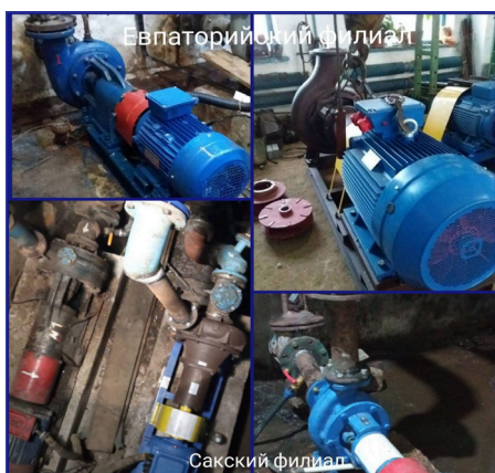
Замена насосного оборудования.
